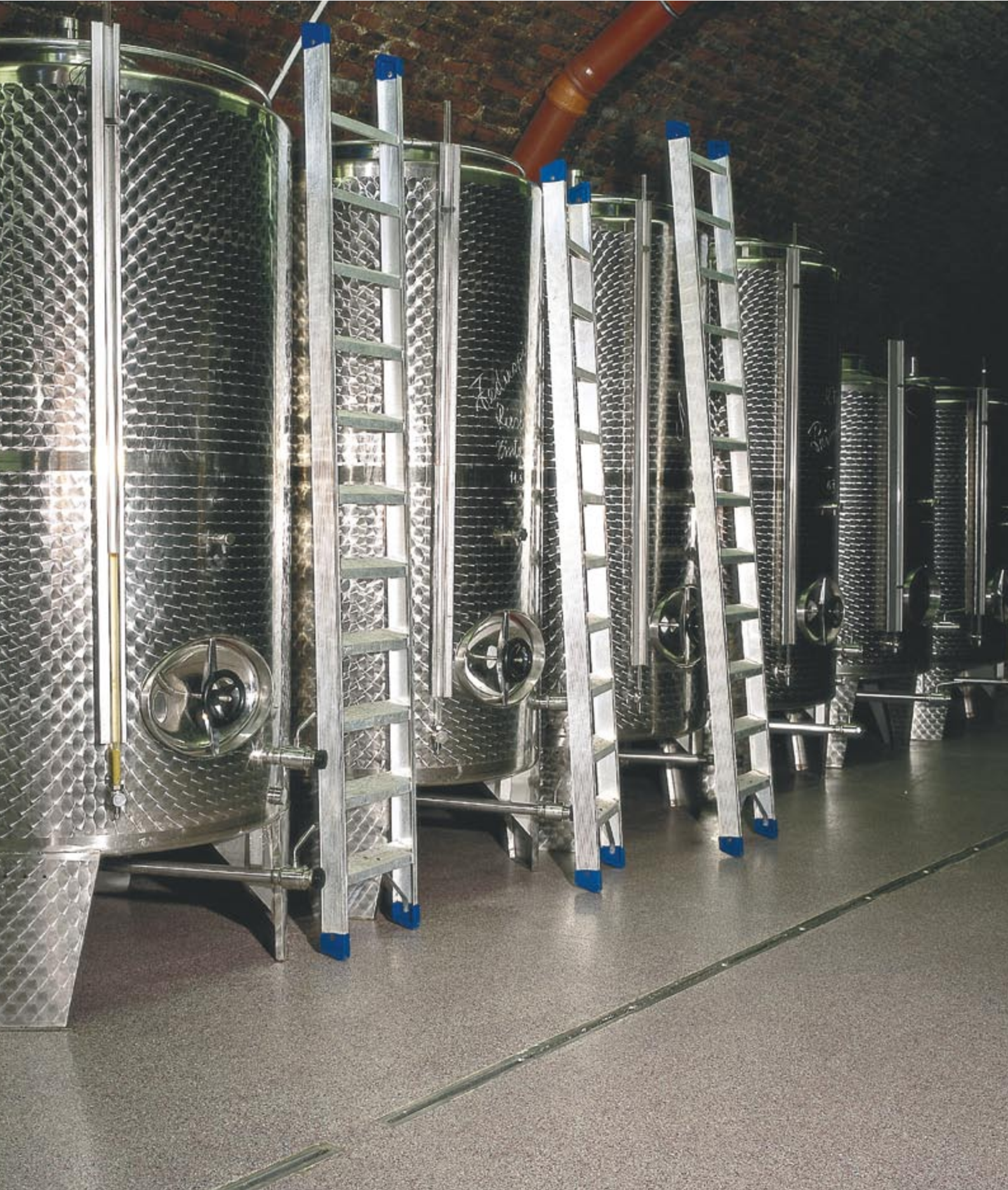
Silikal flooring systems Karl Stierschneider vineyard, Weissenkirchen/Austria
